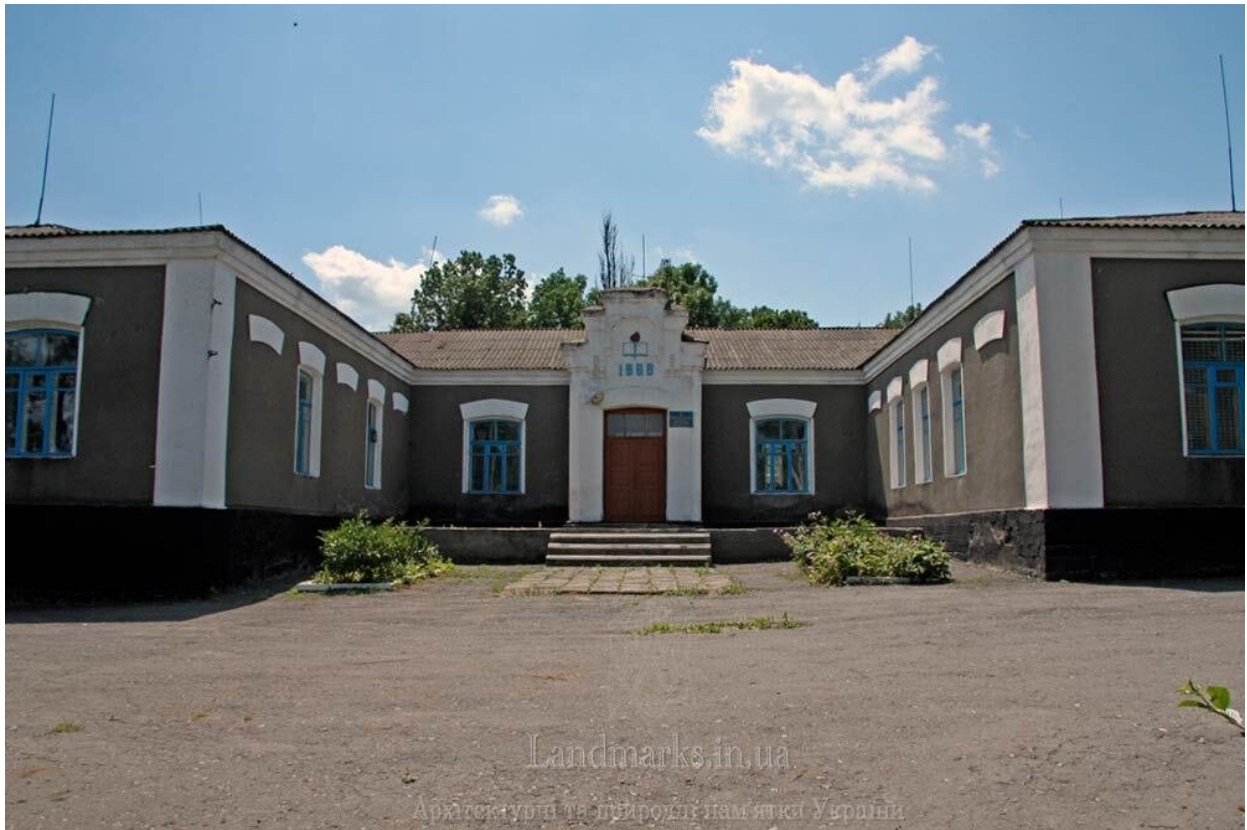
Колишня земська лікарня, рік зведення 1903 р. Заміхів, 2008 р. 10
